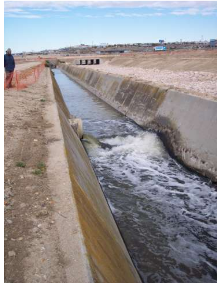
Canal de salida EDAR Sur-Oriental. Arroyo de los Migueles. Rivas Vaciamadrid
